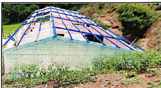
Foto 4: Vista panorámica de la remoción del techo del centro educativo y el pintado de costaneras para el futuro techo.
