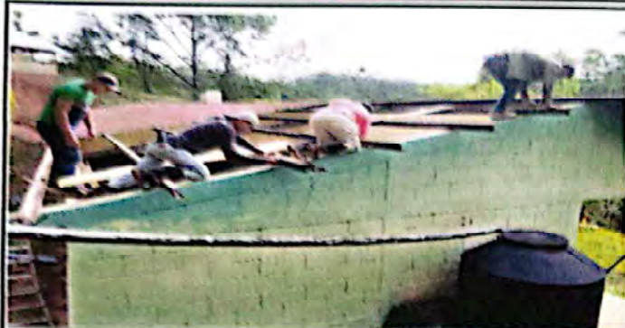
Foto 1: Padres de familia que se encuentran ayudando a remover el techo de las aulas del centro educativo.
