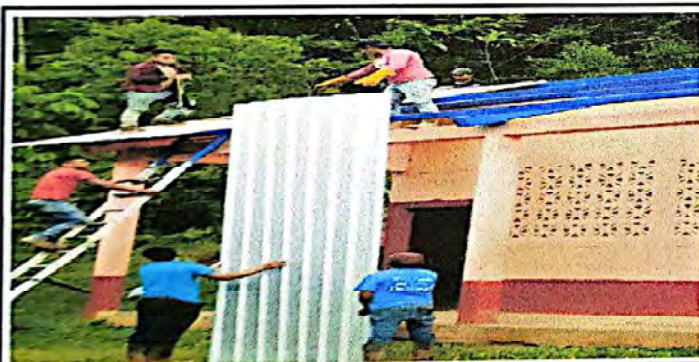
Foto 5: Colocación de láminas troqueladas para el nuevo techo del centro educativo.
