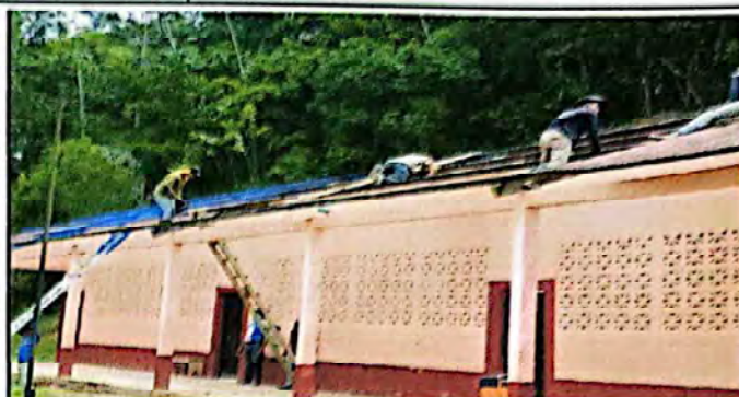
Foto 2: Mano de obra del proveedor para la remoción del techo de lámina del centro educativo.
